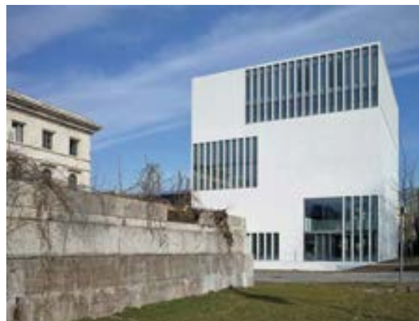
Der markante Neubau bildet einen gewollten Kontrast zu den Relikten der NS-Bauten in der Nachbarschaft
